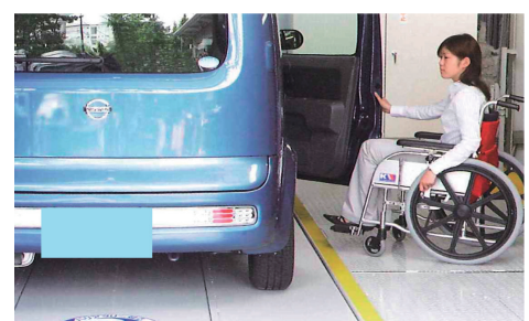
機械式駐車場での車いす利用者対応（フルフラット化）
