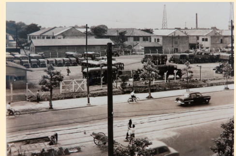
米軍用モータープールの典型例（大手町）
